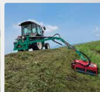
法面の草刈り
